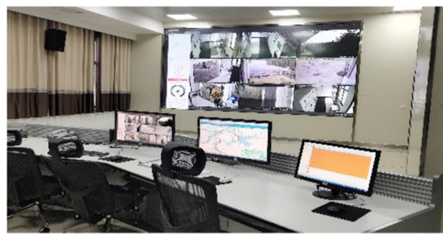
现场工作人员表示，通过这个平台实现各在线监测设备的互联互通，我们通过对实时监测设备数据监测，可以实时在线查看汛期水雨情和安全警戒水位，当各类在线监测设备的监测数据超出预先设置的阈值时，系统会自动发出预警信息并及时通知相关人员进行处理，当接受预警信息时，可以直接通过远程控制系统实时开启相关泵站机组进行城市防洪排涝。在开机过程中相关各级泵站的自动化数据也会实时在调度中心展现，以便运维人员实时管理监控。
